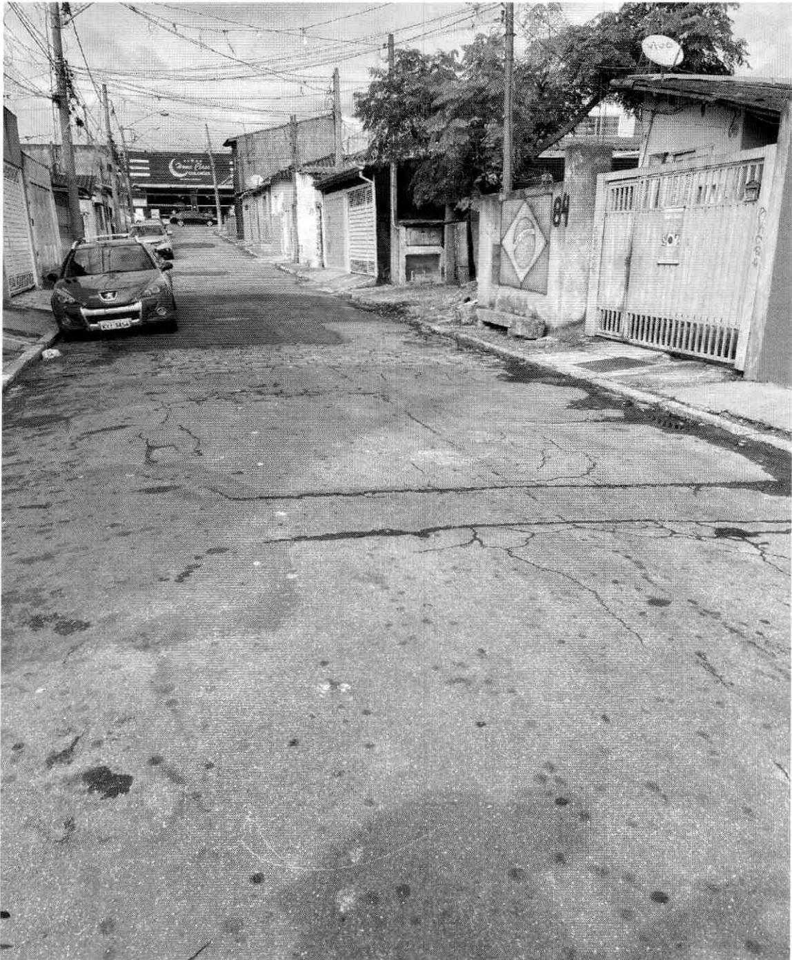
IMPLANTAÇÃO DE ASFALTO NA RUA 25 DE MARÇO BRAZ CUBAS -MOGI DAS CRUZES 29 DE MAIO DE 2023
